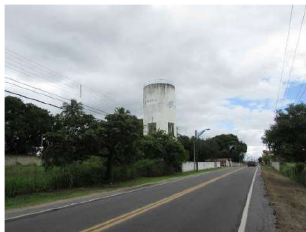
Foto 4.15 - Reservatório de água tratada da CAGECE na entrada da zona urbana de Aquiraz.
