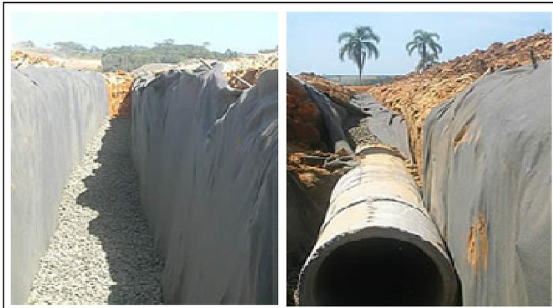
**FIGURA 12** - Execução da drenagem de lixiviado de base.
