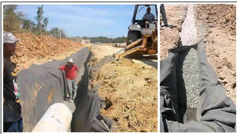
**FIGURA 13** - Execução da drenagem de lixiviado de base.
