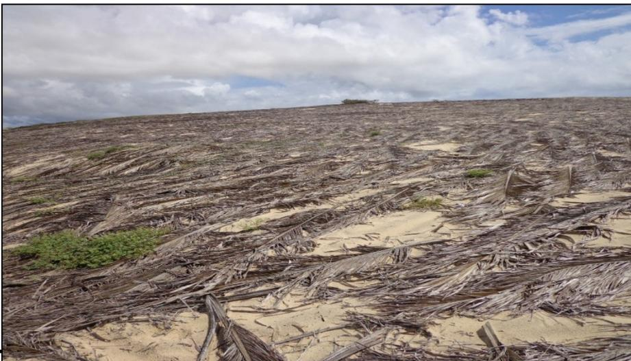
**Foto 16:** Campo de dunas móveis coberto com palhas de coqueiro, para minimizar o transporte de areia para a rodovia CE-025
