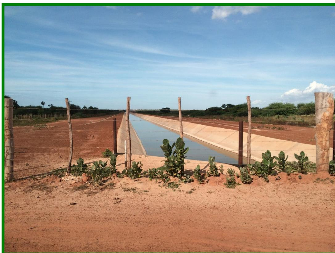
Figura 3.1.: Detalhe do canal de abastecimento que capta água do rio Jaguaribe, perenizado pelo açude Castanhão, cujas suas águas são gerenciadas pela COGERH.
