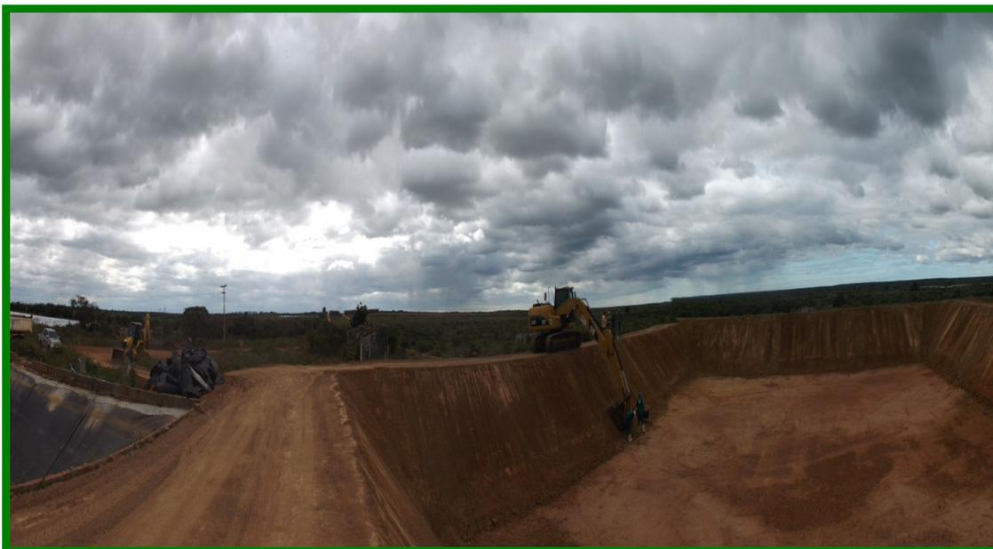
Figura 3.6.: Reservatório para armazenamento de água
