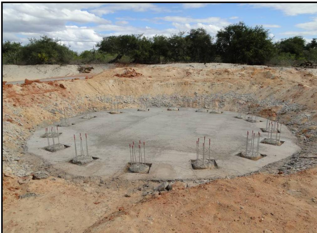
**Exemplo da Armadura do Bloco de Coroamento já com Coroa de Ancoragem (em destaque)**
