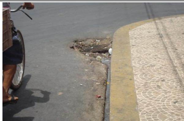
**Foto 14** – Canalização de esgotos para a rede de drenagem pluvial no centro da cidade.
