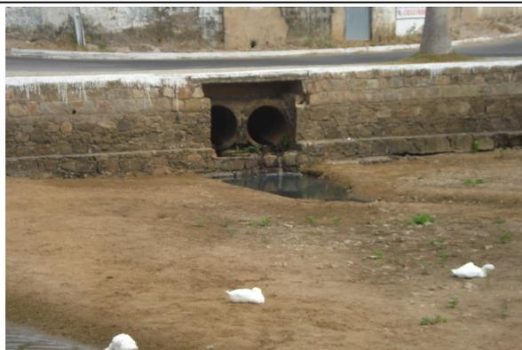
**Foto 13** – Galeria da rede drenagem que deságua na lagoa Dom Pedro I, a qual é utilizada pela população para o lançamento de esgotos.
