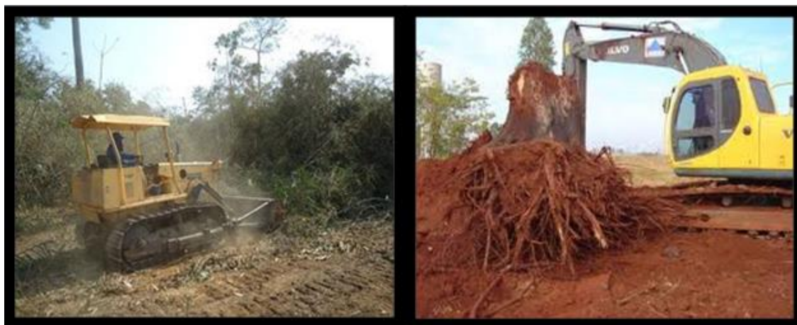
Figura 4.18 - Operações de desmatamento e destoca, respectivamente
