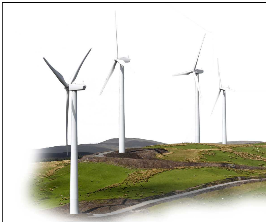
Figura 2.2: Aerogeradores GE 1.6-100. Fonte: GE.
