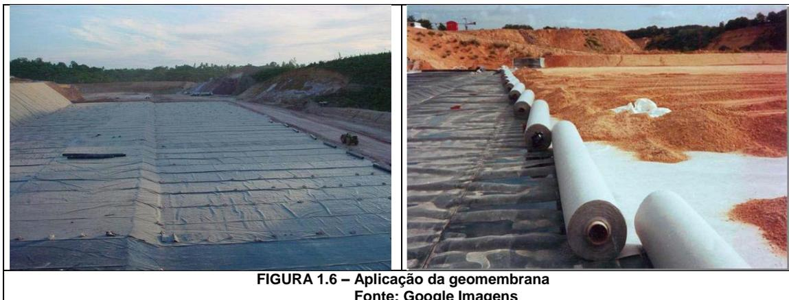
Esse pacote de impermeabilização deve conferir uma proteção tal que a permeabilidade ficará igual ou inferior a  $10^{-7}$ , garantindo a proteção dos corpos hídricos na bacia hidrográfica onde será implantado o aterro sanitário.
