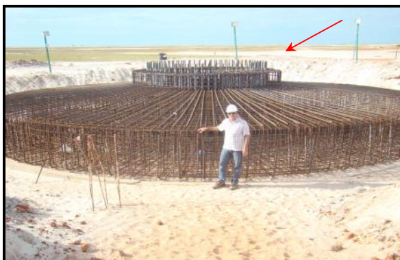
Figura 4.12 – Exemplo da Armadura do Bloco de Coroamento já com Coroa de Ancoragem (em destaque)
