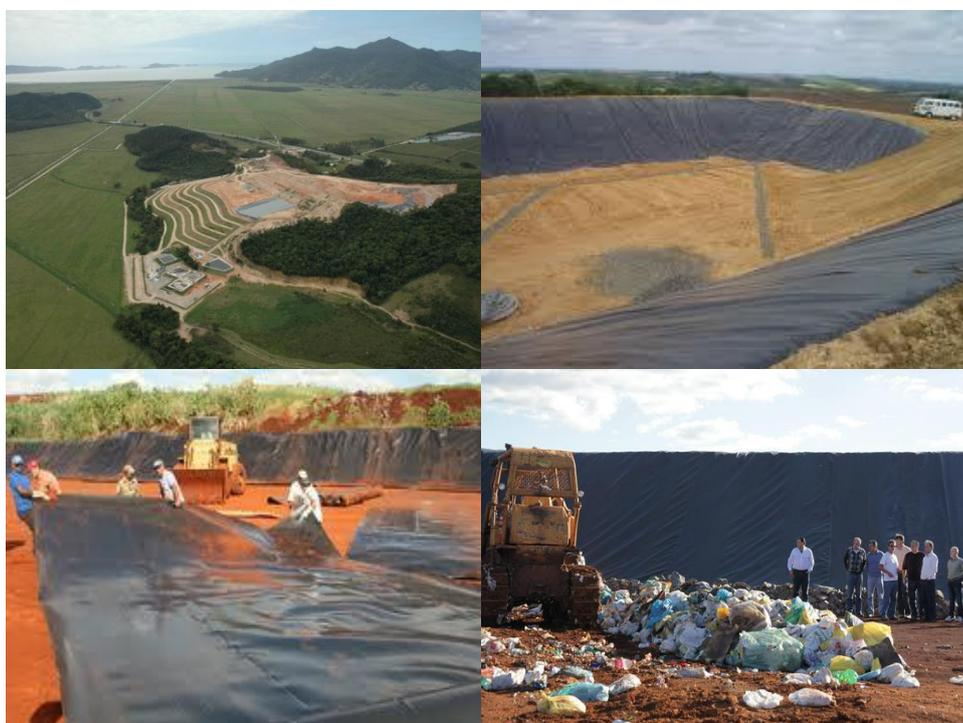
**FIGURA 2.6** Implantação de um aterro sanitário.
