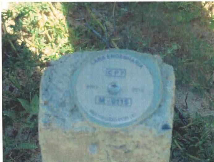
**Foto 05** – Um dos Marcos de concreto implantados nos limites do terreno.
