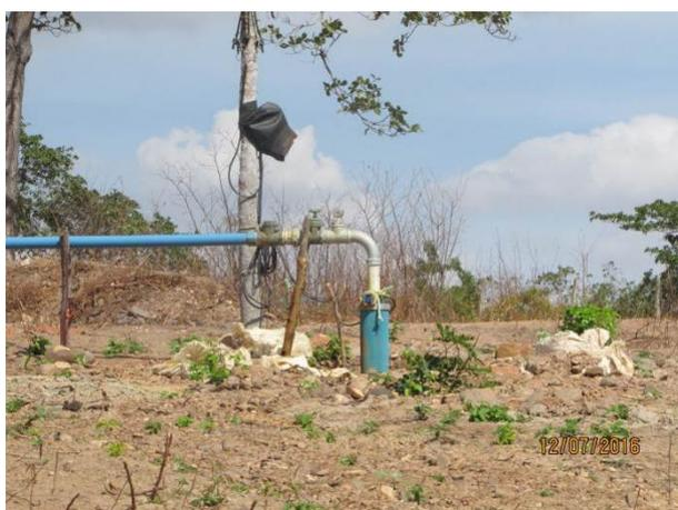
*Poço profundo recentemente escavado com vazão de 22.000 L/h.*
