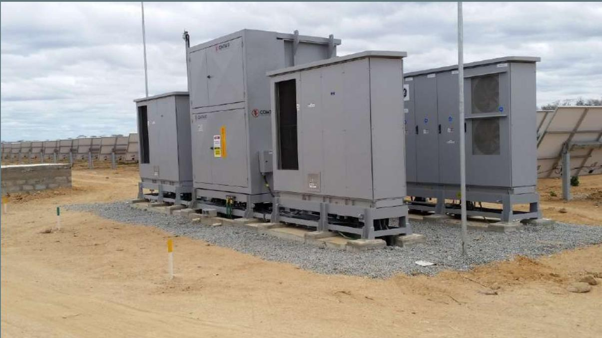
Em seguida a energia produzida é elevada a tensão de 34,5 kV através de transformadores de energia, instalados juntos aos inversores. A partir daí a energia é conduzida por uma Rede de Média Tensão (34,5kV) interna até a Subestação Coletora, instalada no Complexo Solar Fotovoltaico Alex, denominada **SE 230kV Fazenda Alex**.
