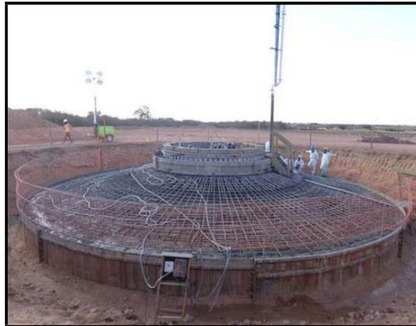
b) Armadura do bloco de coroamento das estacas.
