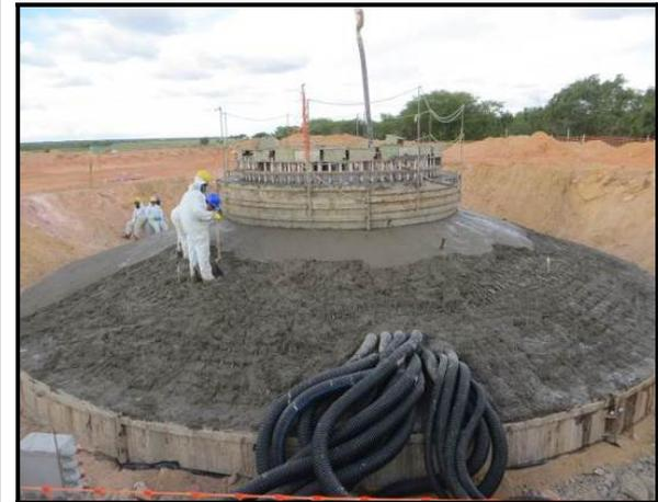
c) Concretagem do bloco de coroamento da fundação do aerogerador.
