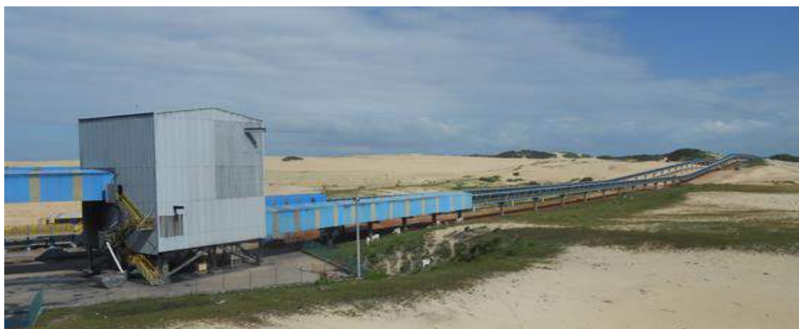
Foto 6.53: Esteiras transportadoras de carvão mineral, que abastecem empresas do CIPP. Fonte: Engesoft, 2016.
