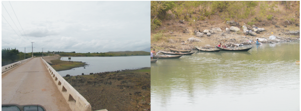
Açude Acaraú Mirim localizado no distrito de Ipaguaçu - Massapê
