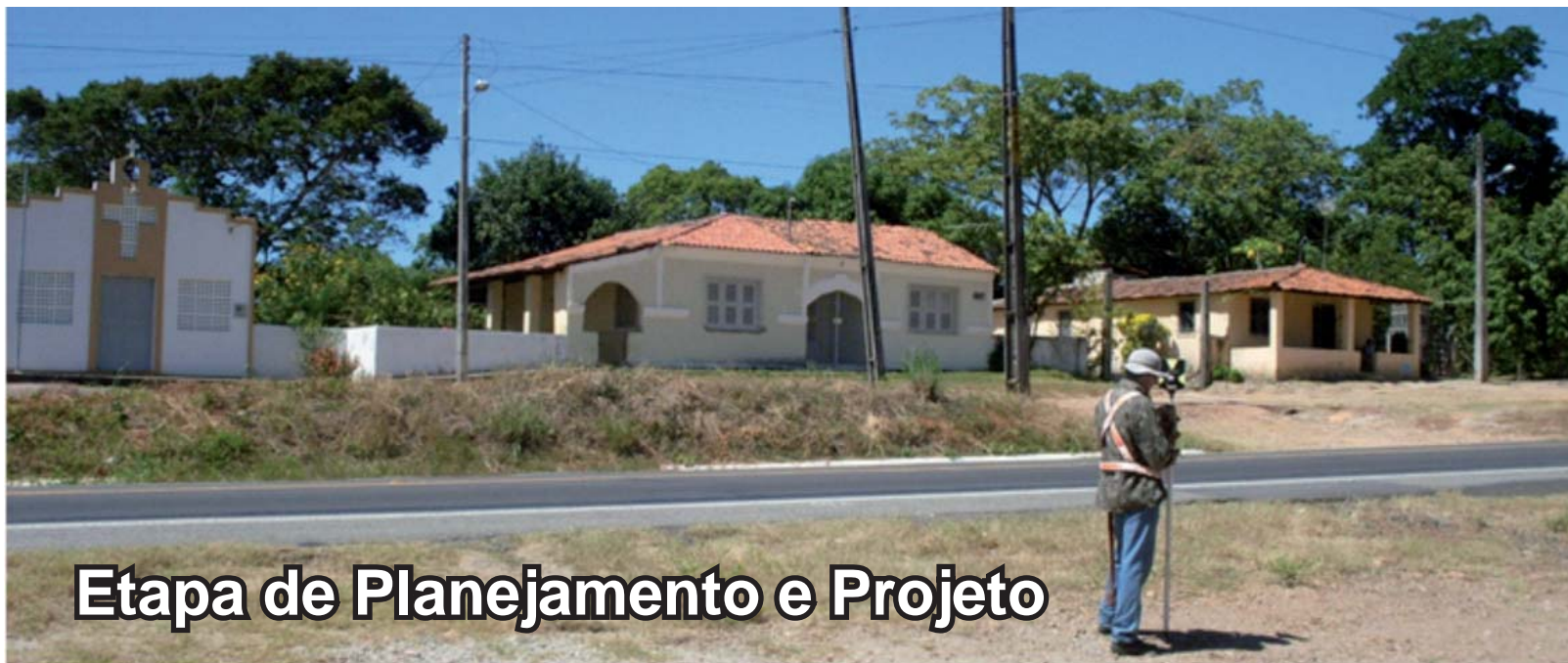
Foto 93 - Levantamento topográfico para a elaboração do projeto de duplicação - Cajazeiras/Pacatuba
