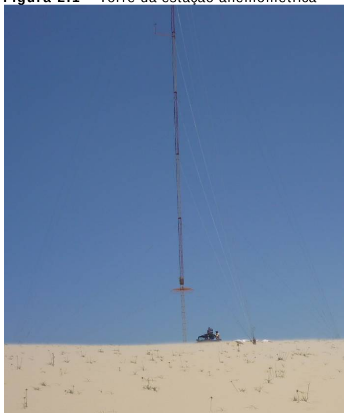
Figura 2.1 – Torre da estação anemométrica
