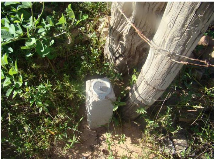
**Foto 04** – Marco de Concreto implantado na área pela equipe de topografia, delimitando a poligonal do terreno.
