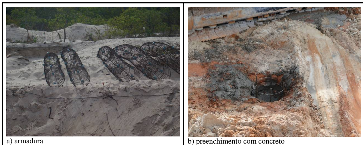
Figura 4.11 – Exemplo de Fixação das Estacas. (a) armadura; (b) preenchimento com concreto CGE SANTO ANTÔNIO DE PÁDUA – TRAIRI / CE
