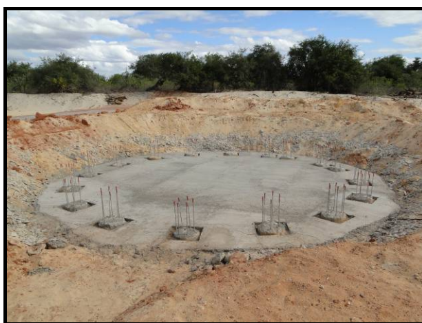
Figura 4.13 – Cimentação das Base com as Armaduras de Engaste CGE SANTO ANTÔNIO DE PÁDUA – TRAIRI / CE
