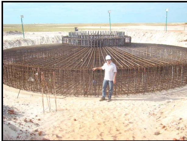
Figura 4.14 – Exemplo da Armadura do Bloco de Coroamento já com Coroa de Ancoragem (em destaque)
