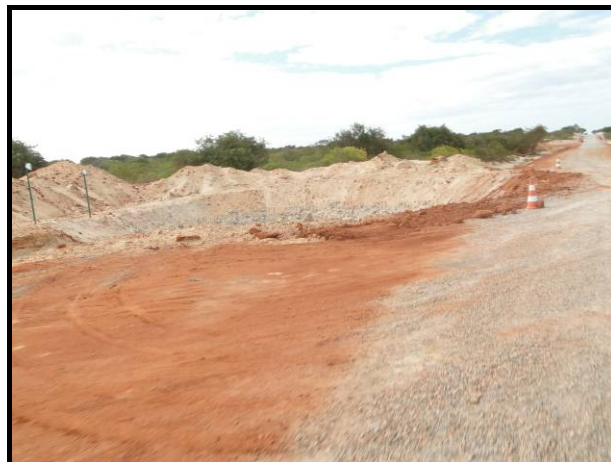
Figura 4.9 – Exemplo de Escavação para Instalação de Aerogerador
