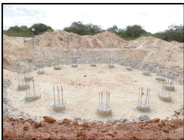
Figura 4.12 – Extensão das Estacas com Armaduras de Engates da Sapata ou Bloco CGE SANTO ANTÔNIO DE PÁDUA – TRAIRI / CE
