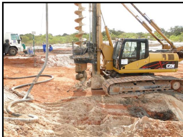
Figura 4.10 – Perfuração das Estacas com Sonda
