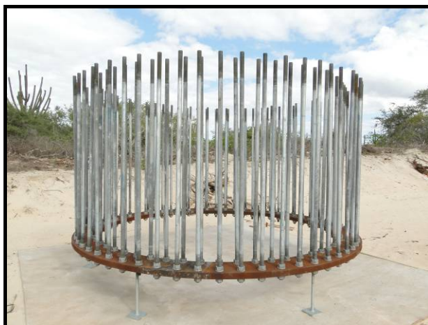
Figura 4.15 – Detalhamento da Coroa de Ancoragem
