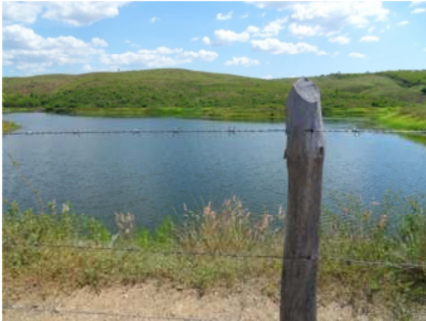
FIGURA 2.9 Açude Sussuarana – Coordenadas UTM: 470150 E/9216554 N). Caririaçu/CE. Janeiro / 2012.
